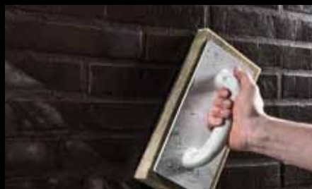
С помощью штукатурной рейки с губкой по диагонали смывают избыточный раствор.
