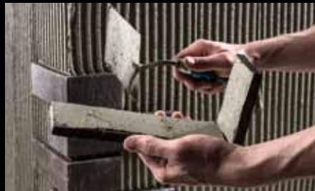
С уголками работают по методу двойного намазывания.
