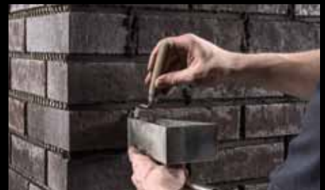
Вертикальные швы проще расширяются с помощью шпателя меньших размеров для расшивки швов.
