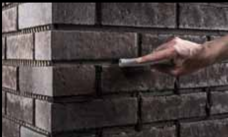
При расшивке швов кельмой можно выработать различные оптические элементы. Будь-то заглубленная затирка или шов, выполненный кельмой, который, как в данном случае, легко вжимается или вытягивается с помощью шланга.
