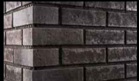
Вид готового шва. Всегда полностью расширяются все стороны.
