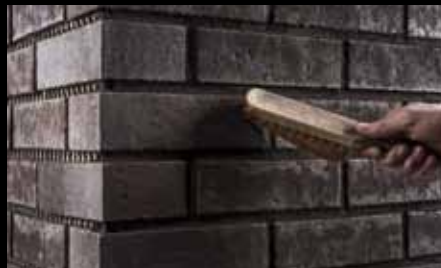
Обметание шва при помощи щетки придает ему соответствующую структуру.
